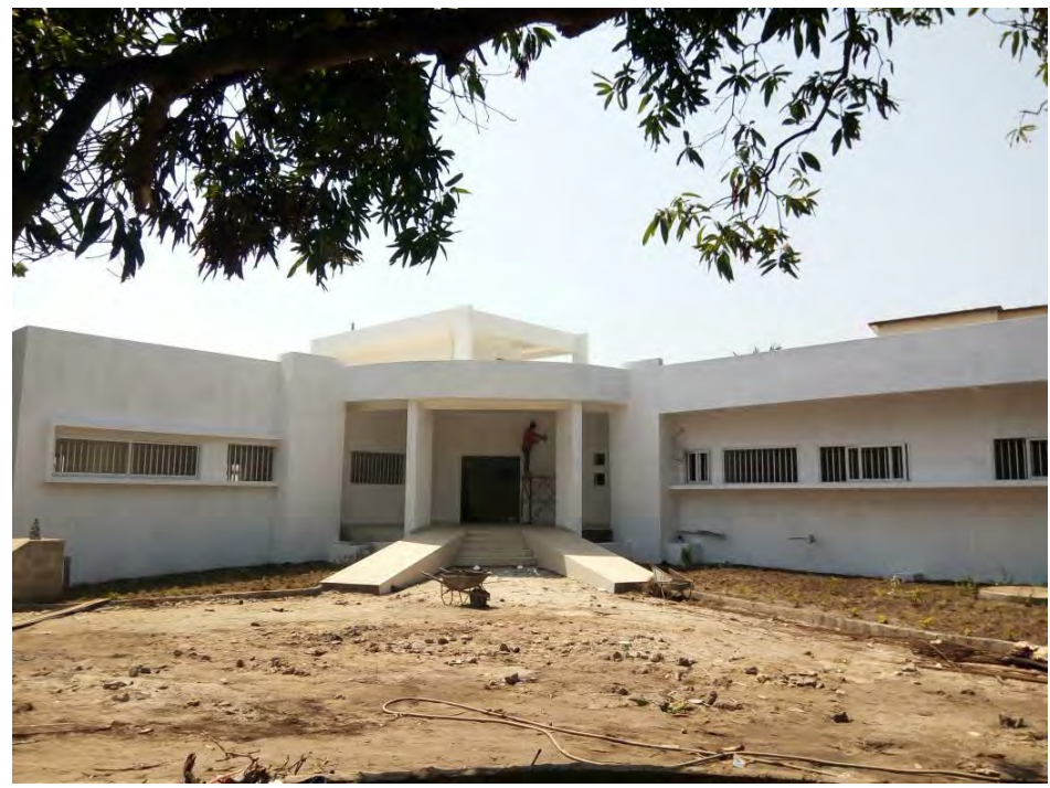
Futur bâtiment de la Direction des Laboratoires
